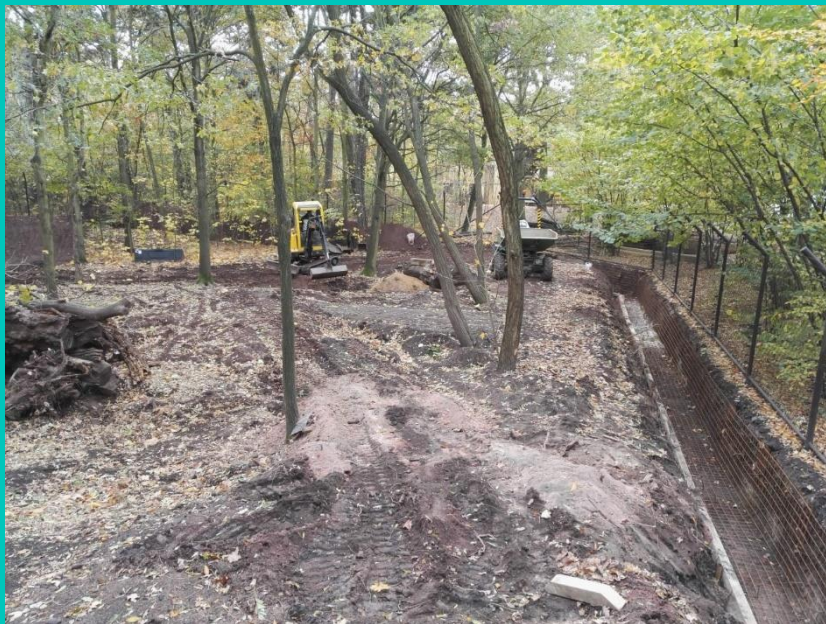
Expozice pro rosomáky – realizace podhrabové monolitické stěny
