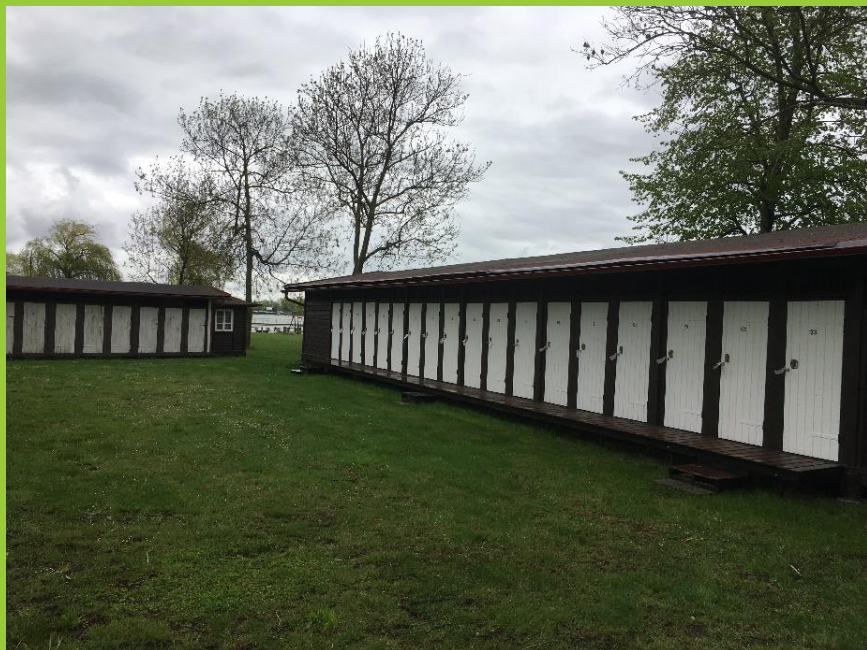
Nátěr převlékacích kabin.
