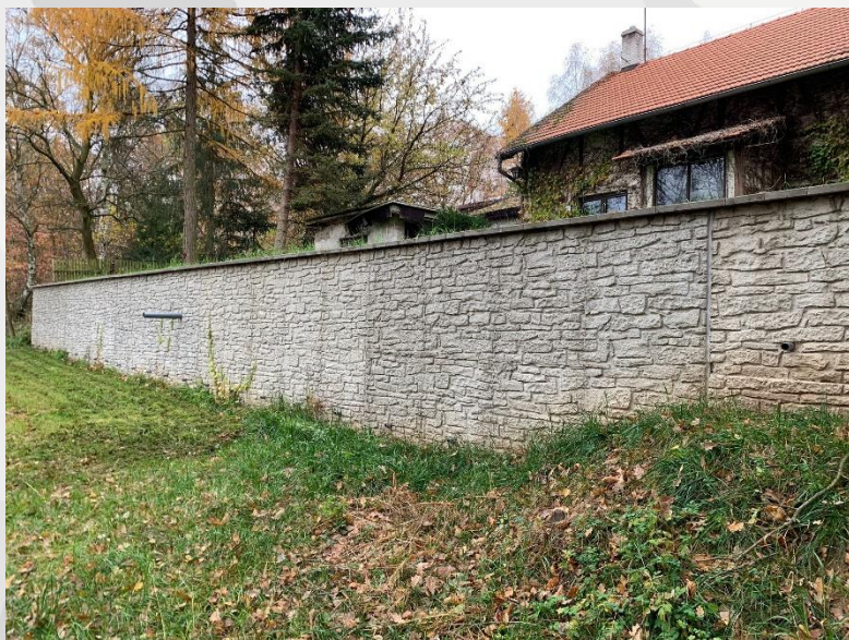
Opěrná zeď Šichtův důl
