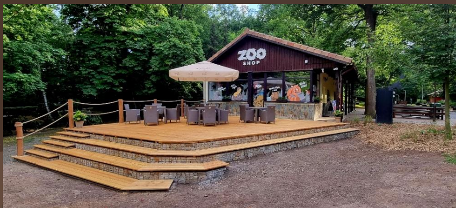
Rekonstrukce terasy u Zooshopu
