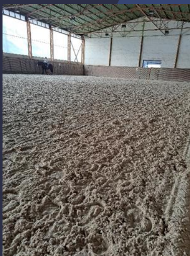
Zhotovení povrchu jízdárny
