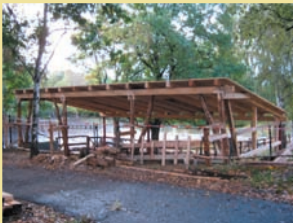
Stavba přístřešku u velbloudů
